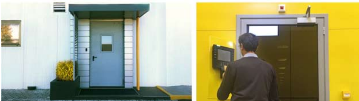
Accesso data center riservato ai Clienti
